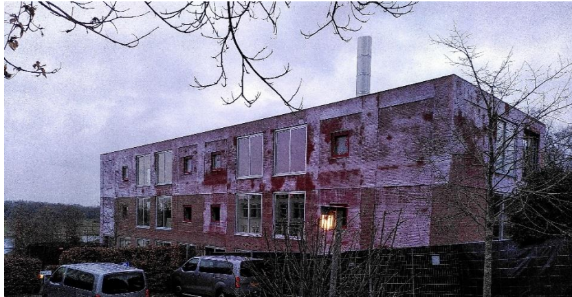
Biomassacentrale in gebouw 7 van landgoed Klingelbeek.
